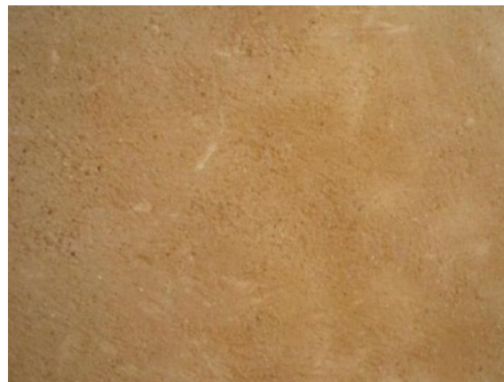
exemple d'enduit de finition à la chaux
