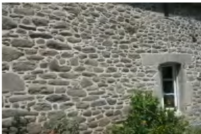
exemple de joints extérieurs chaux/sable
