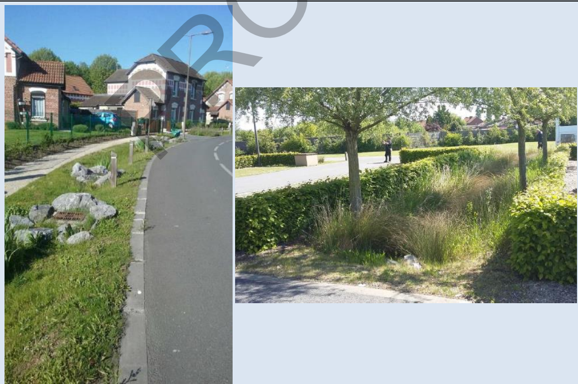
Figure 33 : Illustrations de noues d'infiltrations
