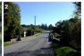
Le pont Kerlo, un passage dangereux pour les piétons et cyclistes
