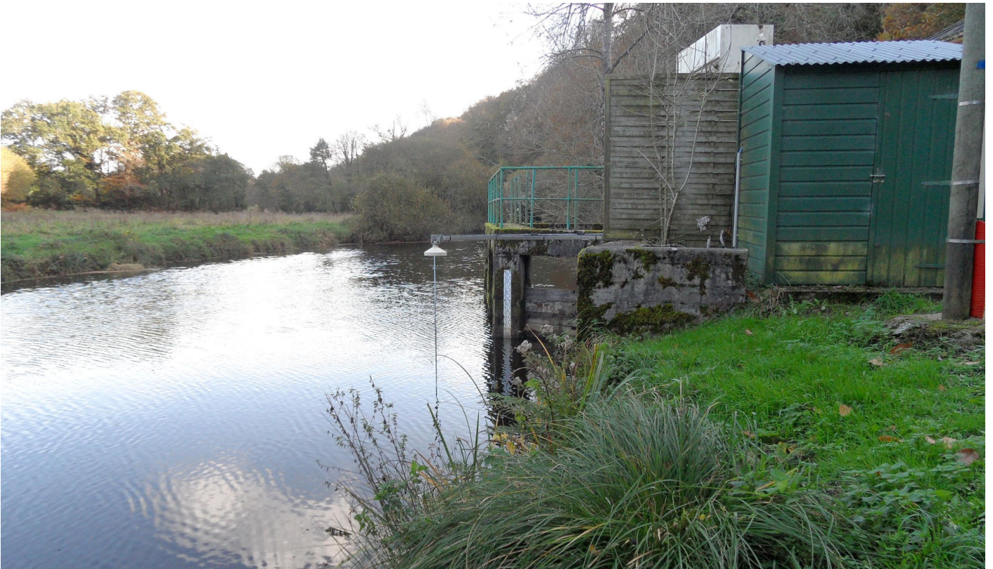
La station de pompage de Kereven, sur le Scorff à l'aval de Plouay, alimente la région de Lorient en eau potable.
