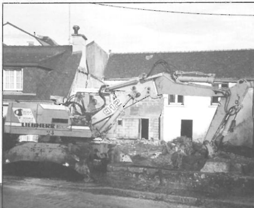
Démolition de l'immeuble Quéro
