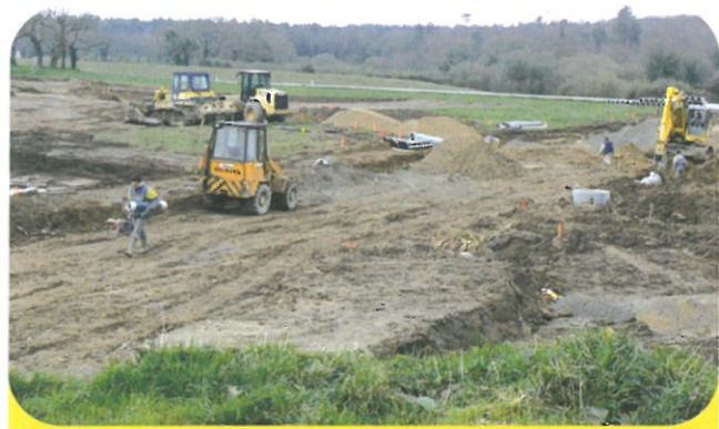
Les travaux vont bon train !
