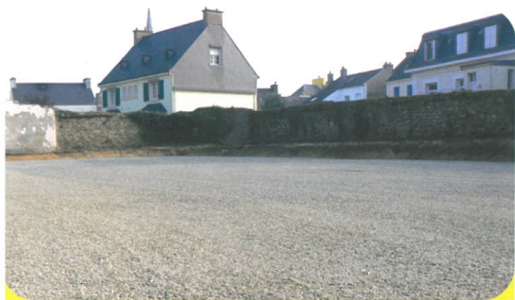
Travaux de finitions
