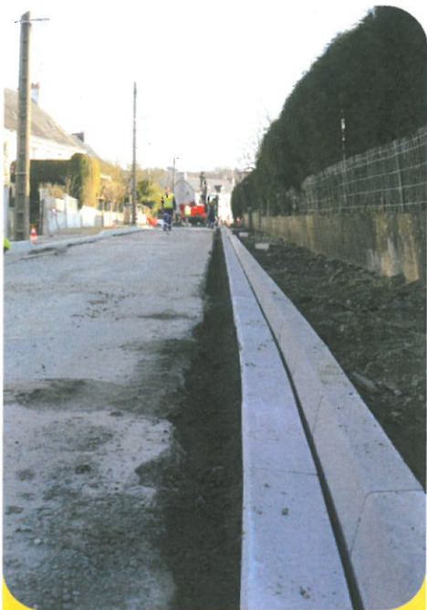
Rue des Sapins. Pose des bordures
