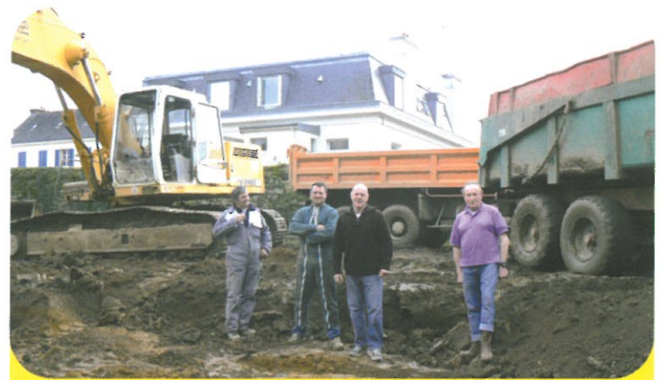
C'est parti pour le terrassement !
