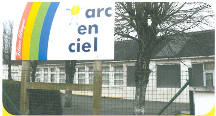
Les ouvertures de l'école seront remplacées.
