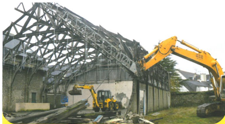
Démolition de l'ancienne halle des sports utilisée autrefois pour le basket-ball
