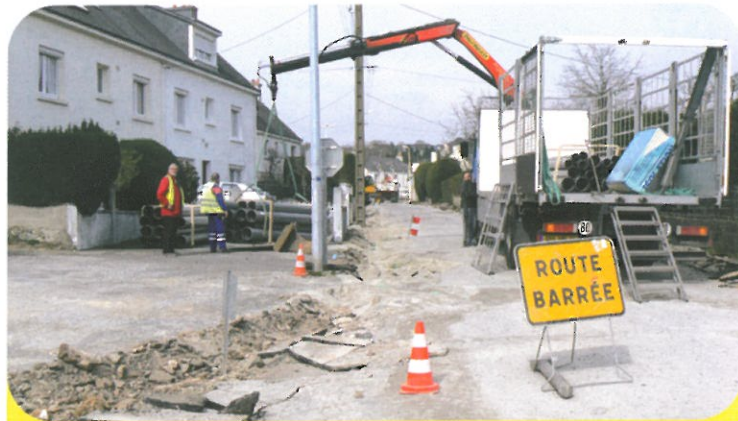
Démarrage des travaux de surface
