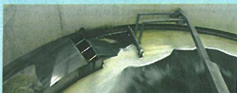
Le **dégrillage** retient les matières les plus volumineuses susceptibles de gêner les traitements ultérieurs ou d'endommager les équipements. Il consiste à faire passer les eaux usées au travers d'une grille dont les barreaux retiennent les éléments les plus grossiers. Après nettoyage des grilles, ces déchets sont évacués avec les ordures ménagères.
