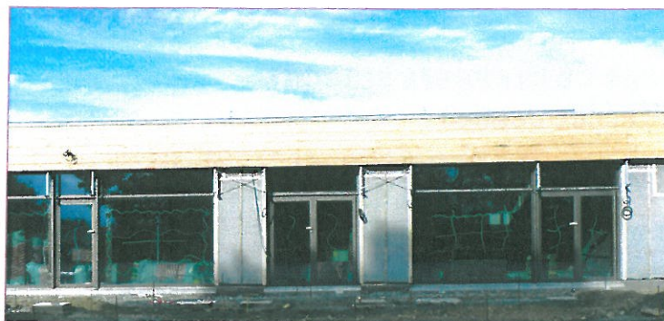
La façade sud et ses baies vitrées
