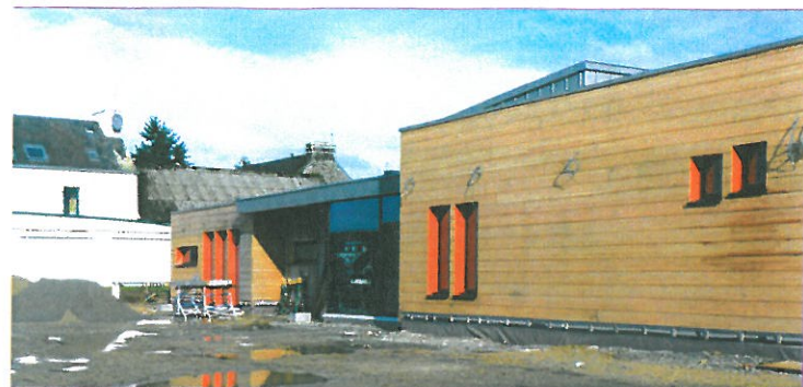
La façade ouest avec la partie accueil du bâtiment
