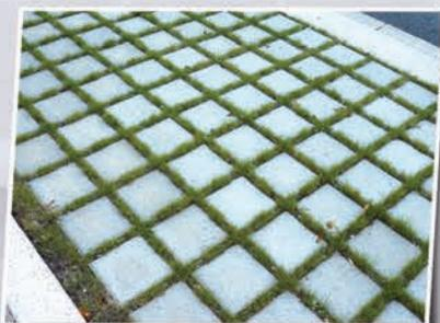
Des zones de pavés engazonnées pour permettre l'infiltration naturelle des eaux de pluie.
