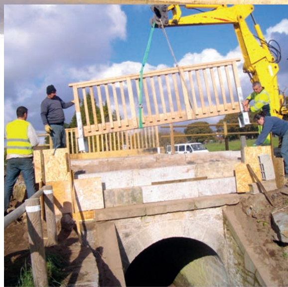
Une belle collaboration entre les services techniques et le chantier Nature et Patrimoine pour améliorer notre cadre de vie.
