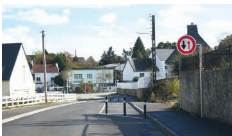
En surface, la rénovation a pour objectif de réduire la vitesse, conformément aux doléances des riverains. Ceux-ci ont préféré l'implantation de passages de courtoisie avec rétrécissement de la chaussée à 3,5m à celle de plateaux ralentisseurs.
