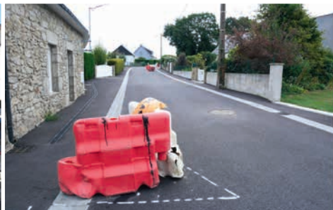
Certains aménagements ont fait l'objet de période d'essai et ont été marqués de façon provisoire. Cela permet un ajustement précis des zones de stationnement par exemple.
