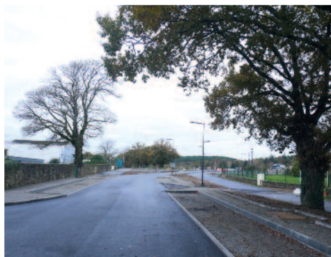
Tout comme la rue Hélène Le Chaton, la rue de Manehouarn fait la part belle aux déplacements doux : de larges allées sont réservées aux piétons et aux cyclistes, les mettant à l'écart de la circulation routière.
