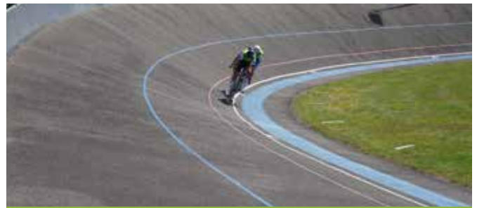
Réfection de la piste du vélodrome
