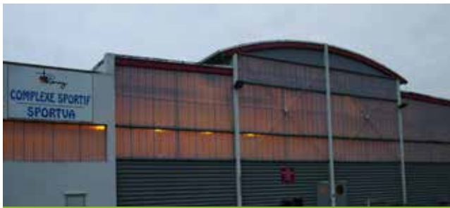
Remplacement des radians gaz par des émetteurs à eau chaude
